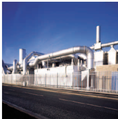
Industrial Fan Control
