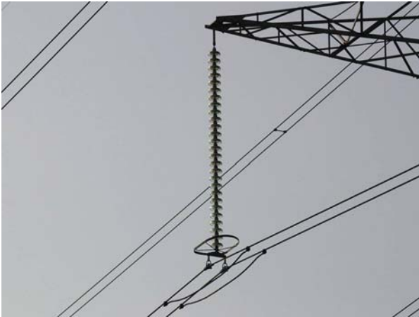
Rys. 2.9. Łącuchy izolatorów linii WN: a) przelotowe linii 220 kV, b) odciągowe linii 220 kV, c) przelotowy linii 400 kV, d) odciągowy linii 400 kV
