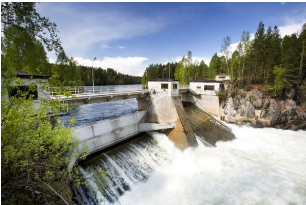
Rys. 2.1. Zapora elektrowni wodnej [6]
